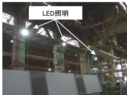
LED照明設置(工場側灯への活用)
