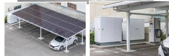
対象施設：パナソニック(株)京都ビル
