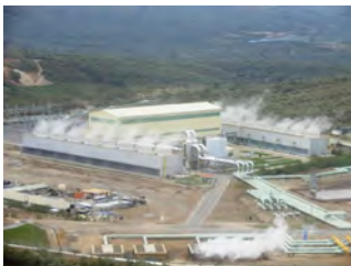
オルカリア地熱発電所 (ケニア) 出典：電機・電子温暖化対策連絡会
