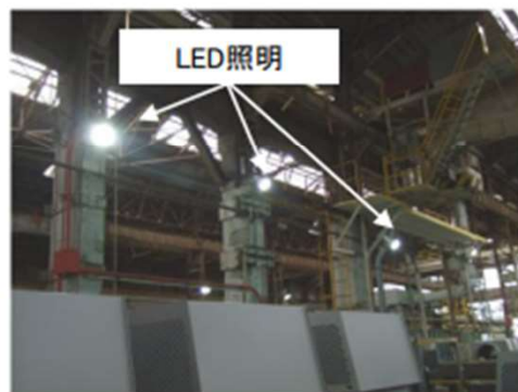
LED照明設置(工場側灯への活用)
