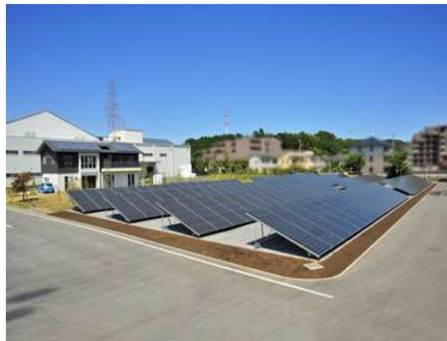
2011年に488kWの太陽光発電設備を、約2ヶ月の短工期で設置。
