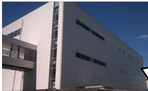
ロボット第2工場
