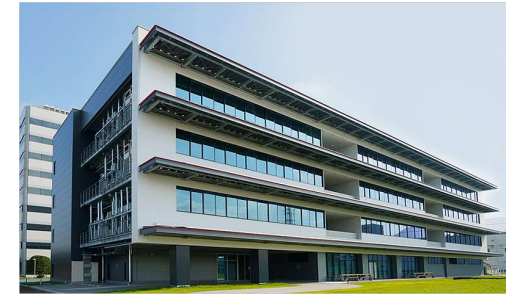
ZEB関連技術実証棟『SUSTIE』
